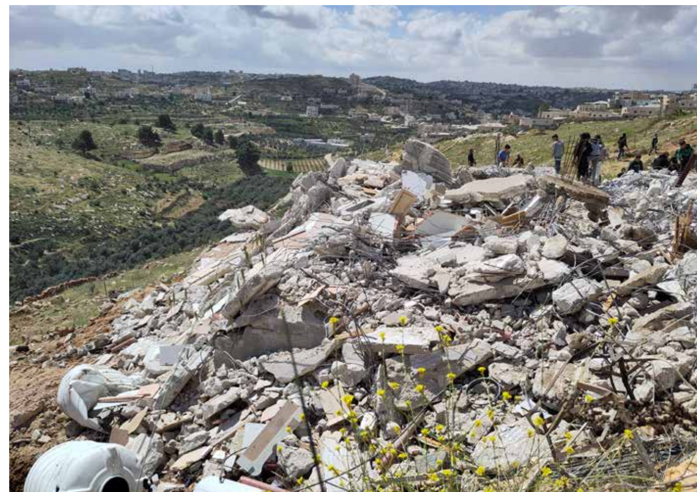
Husrivning utanför Masafer Yatta.
